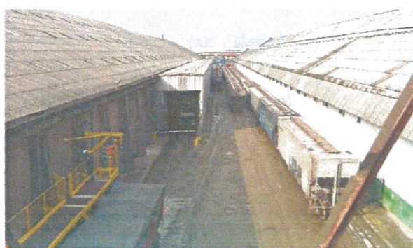
1.2- Túnel de carregamento
